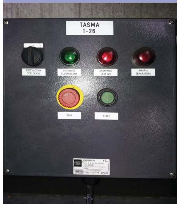
Skrzynka sterowania lokalnego
