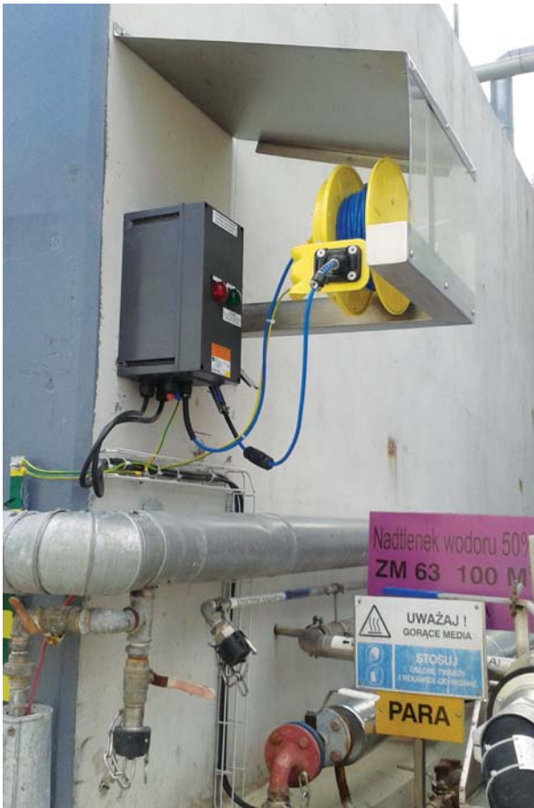
Zaprojektowany kontroler uziemienia cysterny
