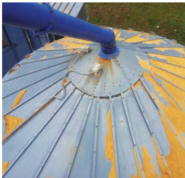
Silos peletu przed i po modernizacji
