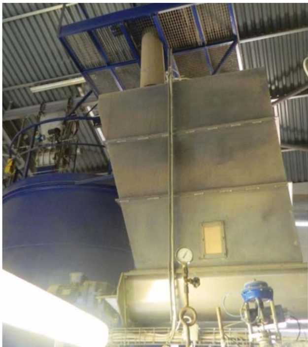
Zabezpieczony zsyp trocin nr 2 przed i po modernizacji
