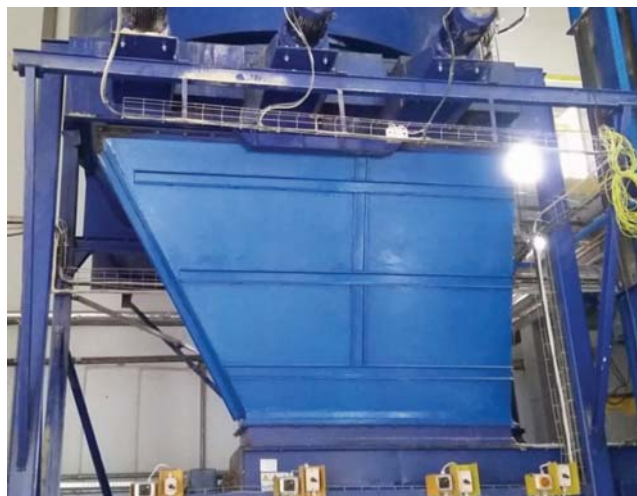
Zabezpieczony zsyp trocin nr 1 po modernizacji
