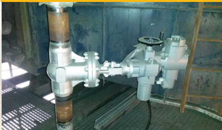
Dolot pary do parowych podgrzewaczy powietrza 5XL2 z napędem AUMA NORD MATIC
