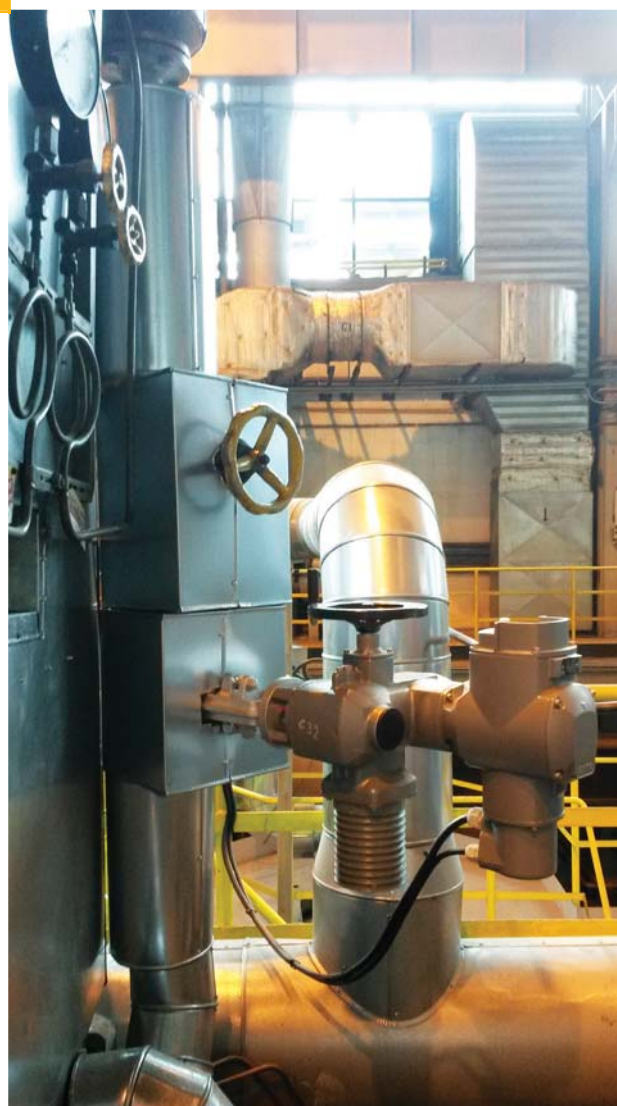
Para do smoczka parowego 5SM1. Jeden zawór wymieniony, drugi pozostawiony
