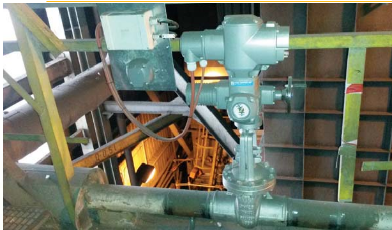
Dolot pary do parowych podgrzewaczy powietrza 5XL1 z napędem AUMA NORD MATIC
