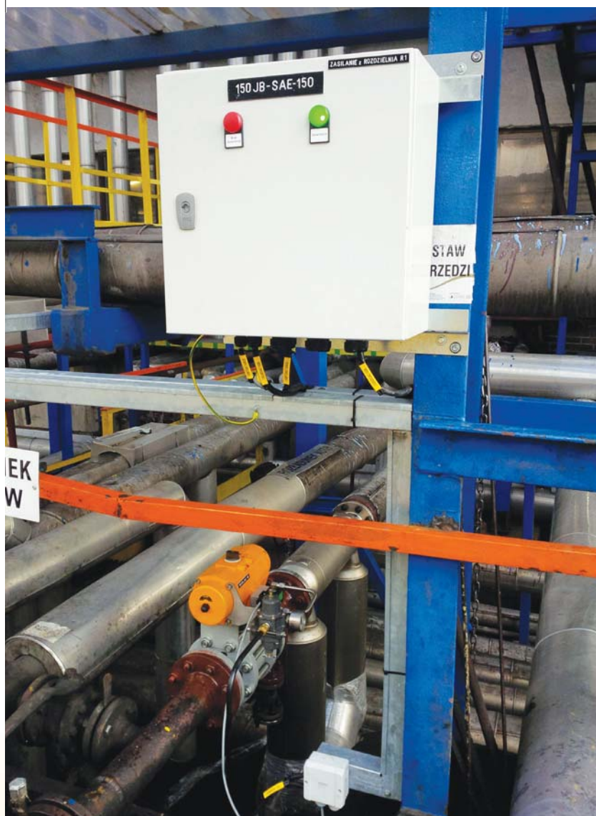
Lokalny wskaźnik zestawienia trasy oleju informujący o możliwości uruchomienia układu dozującego (przepływomierz zainstalowany na rurociągu)
