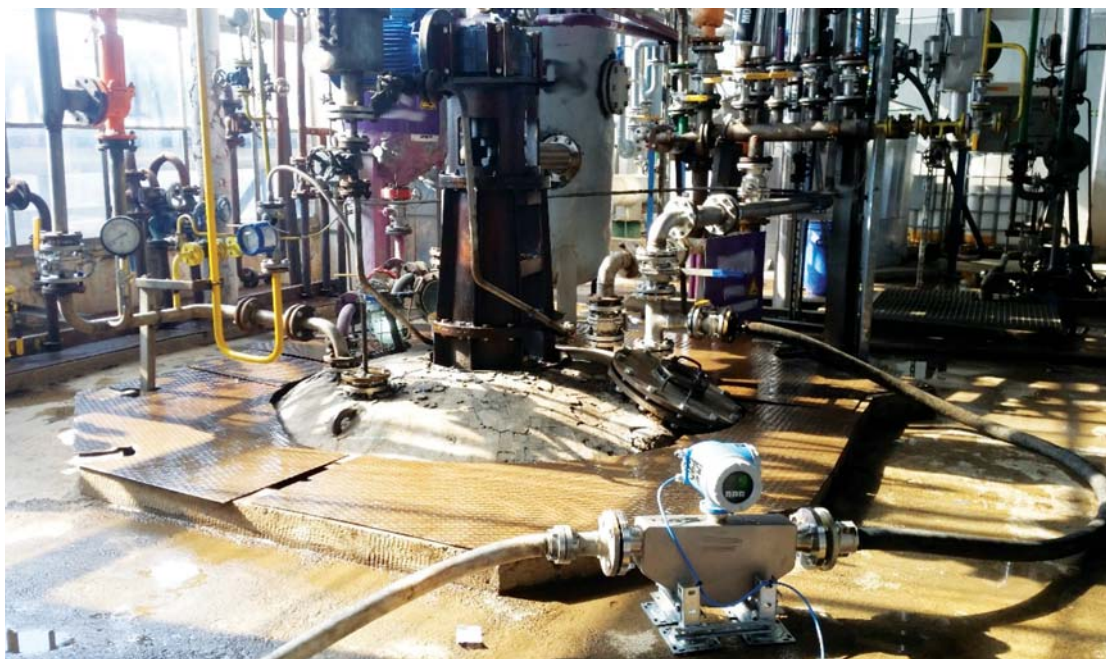
Instalacja podczas wzorcowania przepływomierzem masowym
