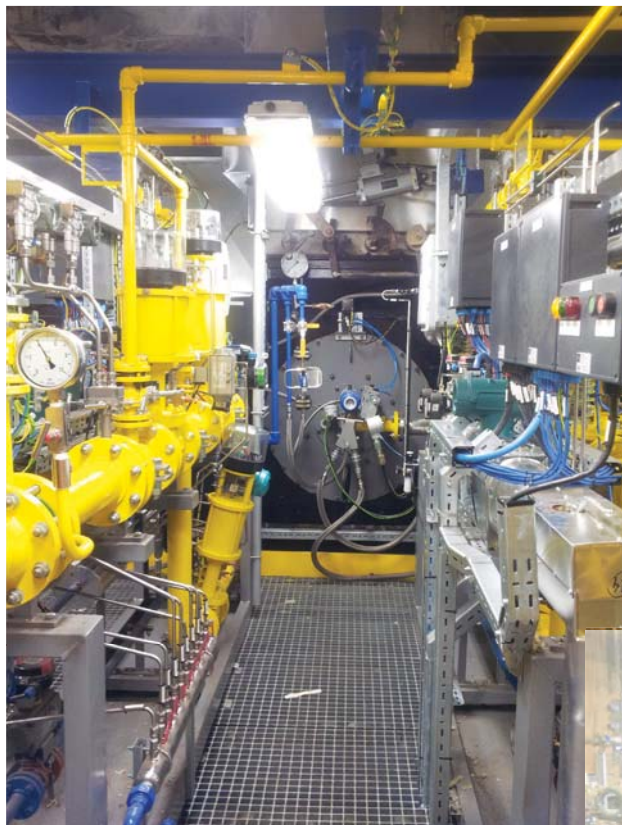
Palnik gazowo-olejowy na kotle K2
