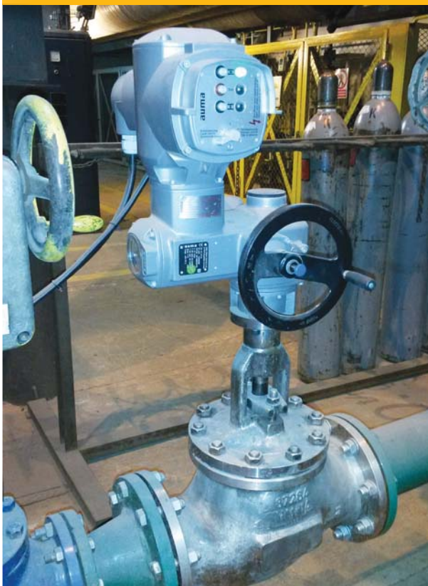
Zawór z napędem na rurociągu z wodą zdeminalizowaną wykonany ze stali kwasoodpornej
