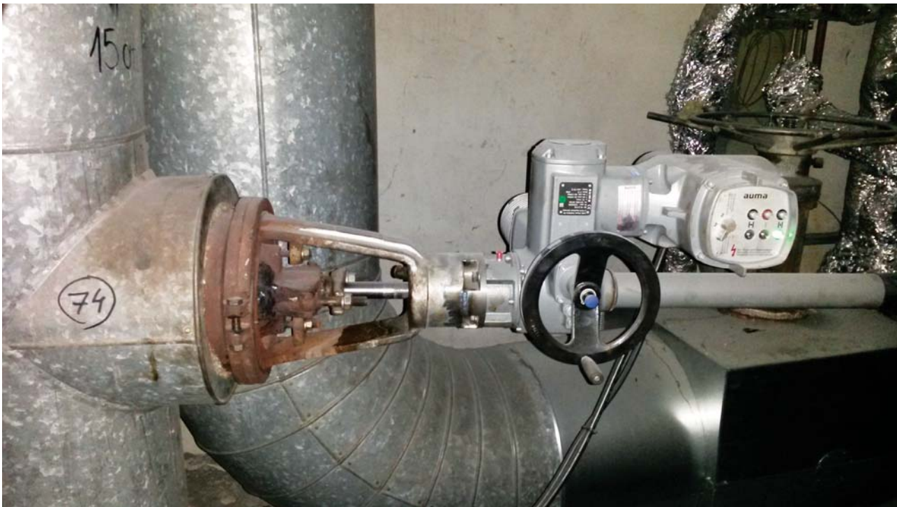
Doposażenie zaworu sekcyjnego na kolektorze 15 ata w napęd
