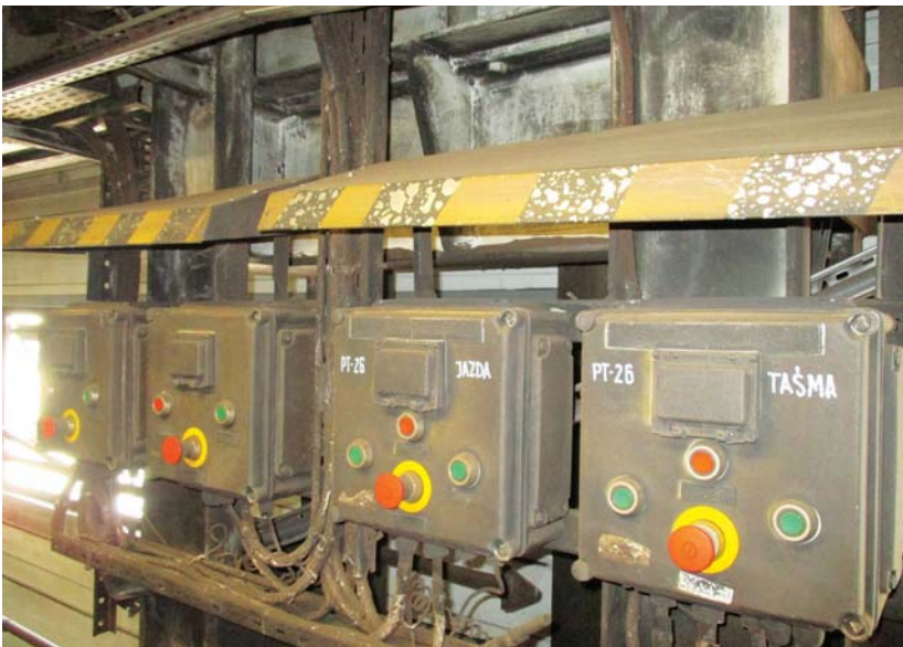
Skrzynki sterowania lokalnego
