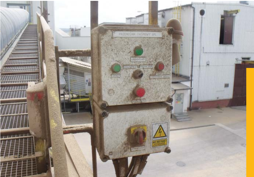
Skrzynka sterowania lokalnego przenośnika taśmowego
