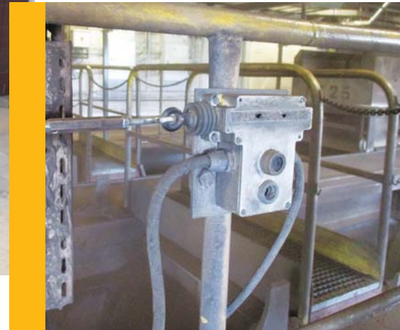
Wyłącznik linkowy przenośnika taśmowego
