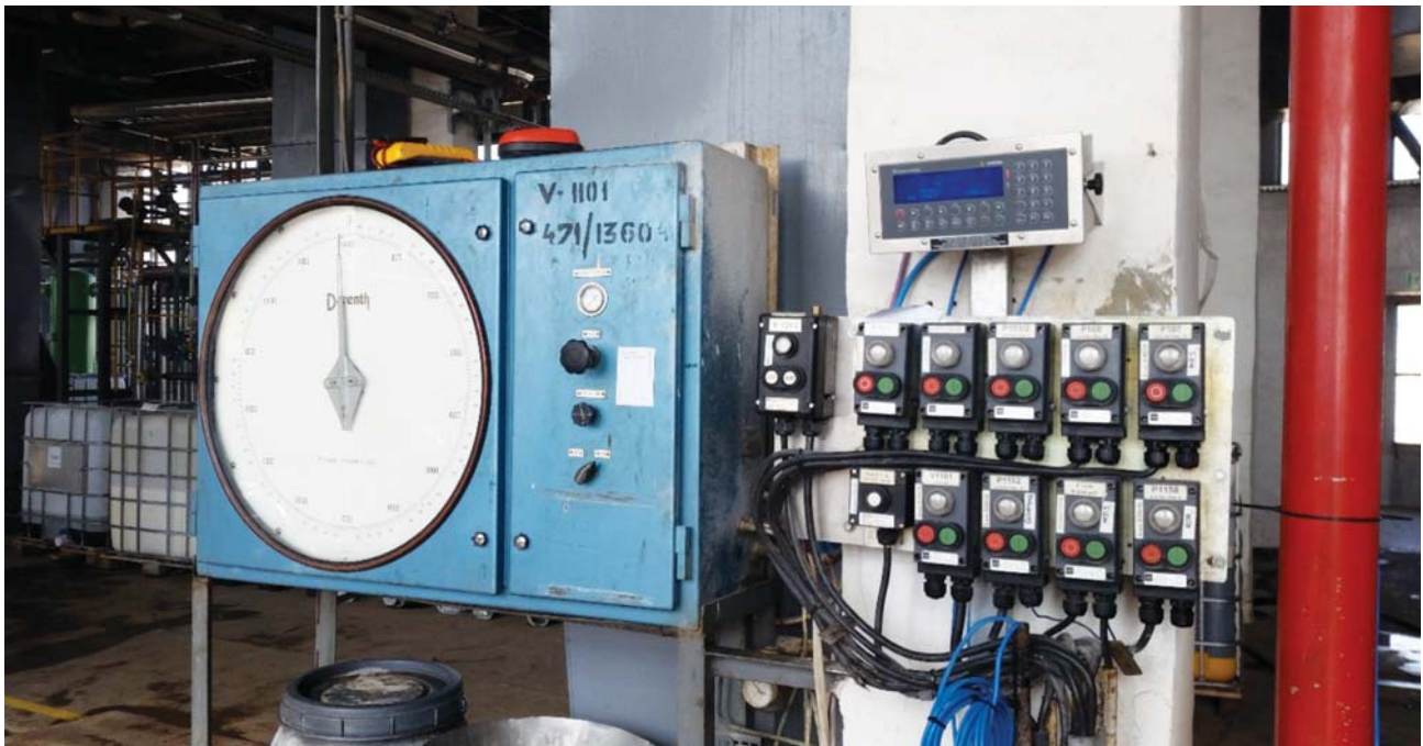
Stare i nowe – wskaźnik wagi pneumatycznej i elektroniczny wskaźnik wagi tensometrycznej
