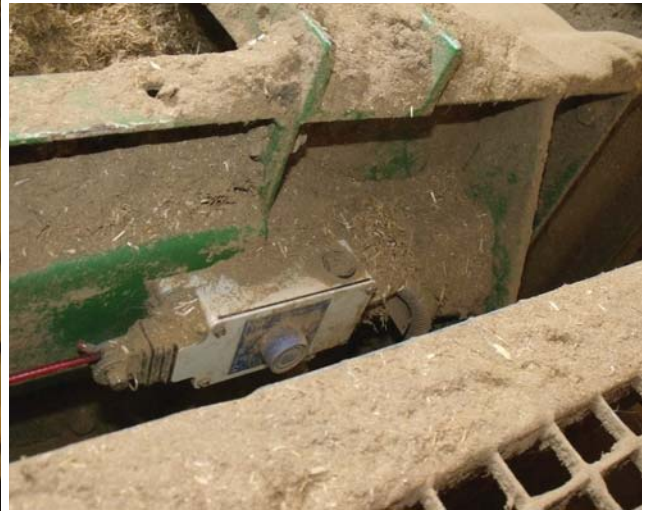
Wyłącznik linkowy. Instalacja biomasy
